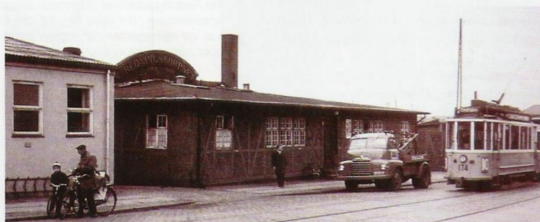
De ældre bygninger i Tietgensgade 67 havde tjent Falck som hovedstation fra 1916. I 1962 flyttede man til nybygningen Falck-Huset på Polititorvet.
